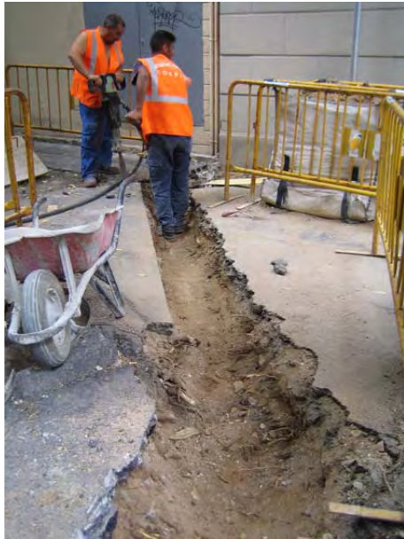
FOTO 1. Vista de la rasa durant el procés d'execució
